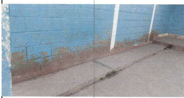
Foto 4: Pinturas en muros exteriores e interiores.
