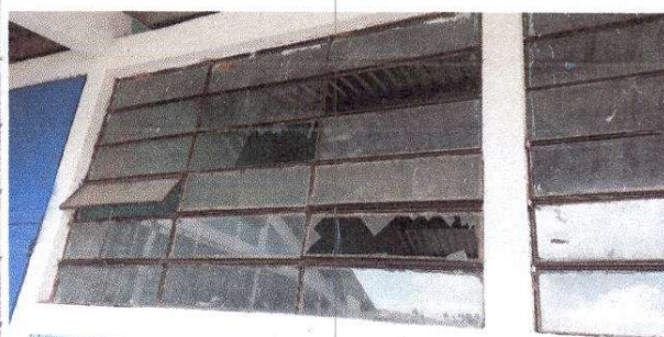
Foto 2: Sustrucción de Vidrios.
