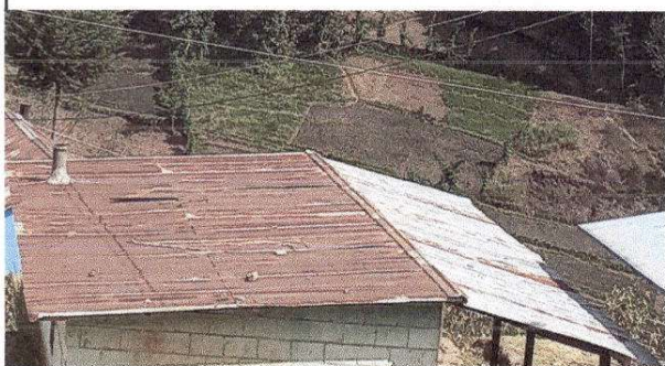
Foto1: Sustrucción de lámina, por lámina troqueladaaluzinc 26
