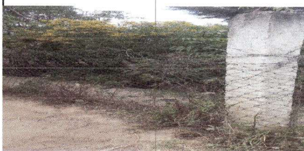
Foto 6: Reparación de tubo hg y malla galvanizada.
