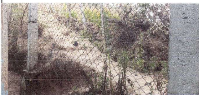
Foto 5: Reparación de tubo hg y malla galvanizada.
